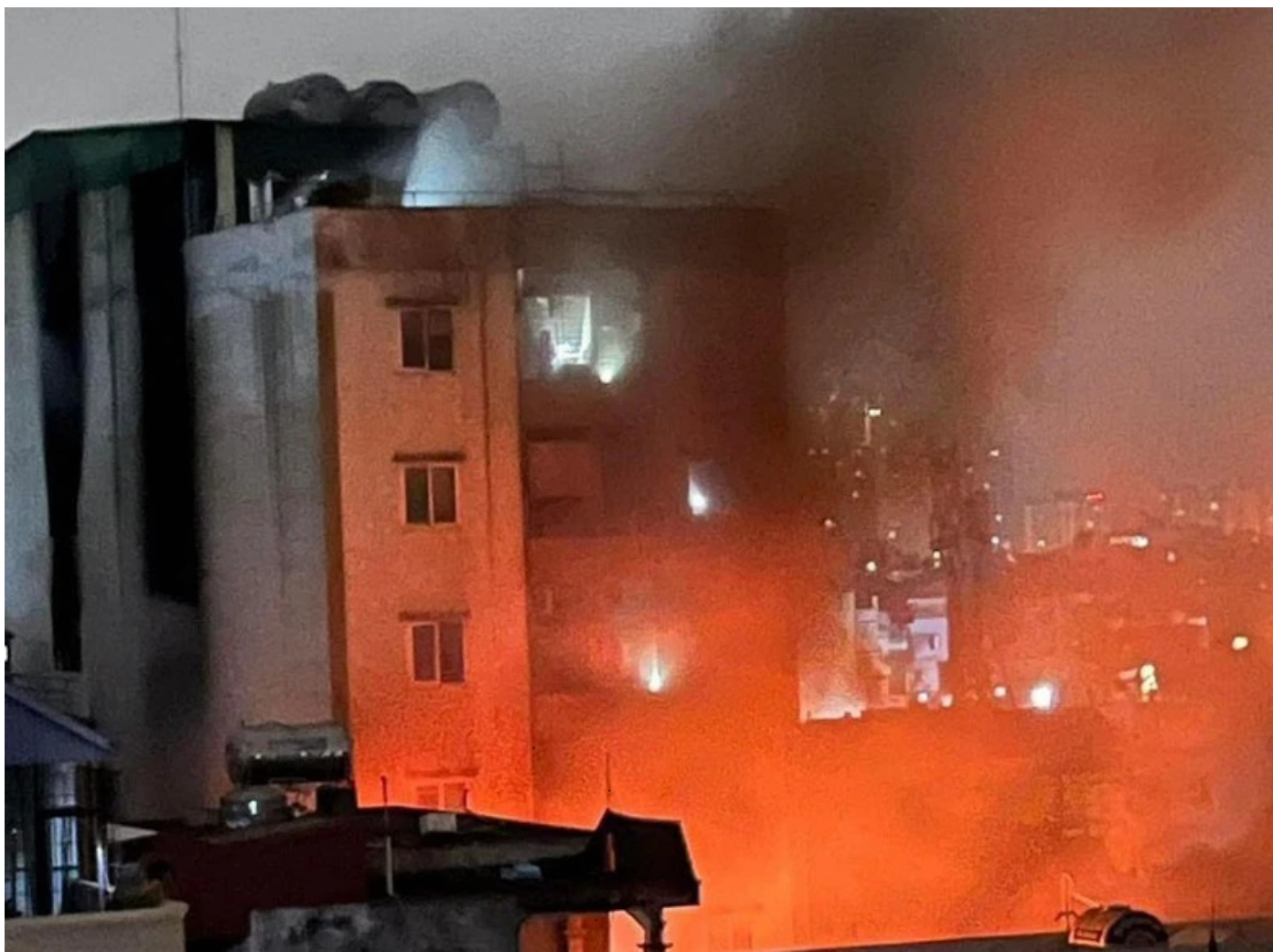
Hiện trường vụ cháy
